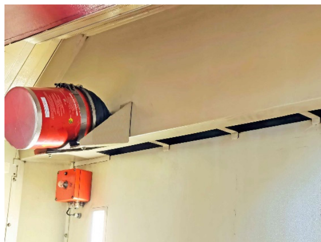
Съвсем незабележимо, но много ефективно: Входните отвори за климатизацията околна въздух са разположени под пожарогасителната система (Снимка: Клаус Волрат)
